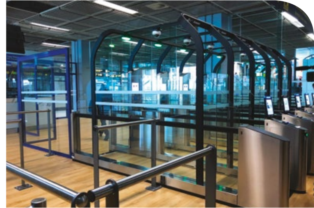
Aéroport régional précurseur en la matière. AMP a installé 15 sas PARAFE en 2017. 8 nouveaux sas seront installés en 2018.
