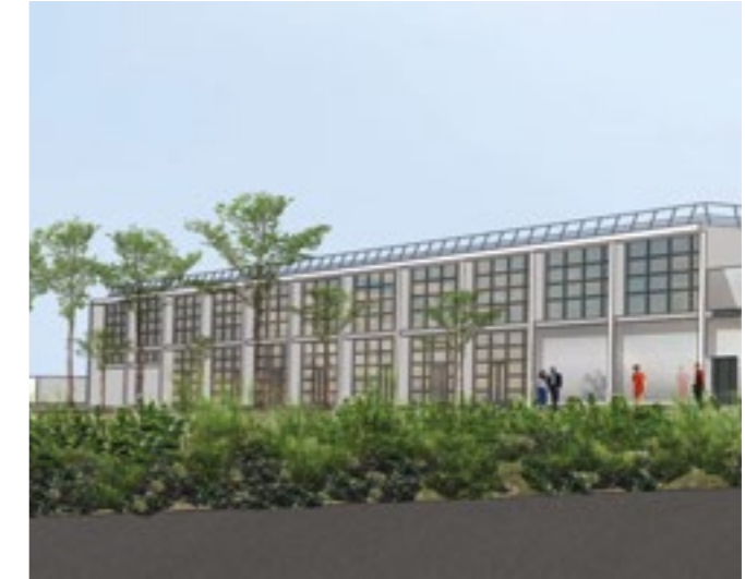
Extension et modernisation des salles d'embarquement du terminal 2.
