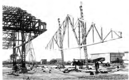
► Travaux de réaménagement de l'aéroport
